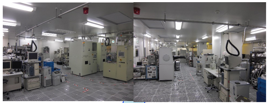
合同棟2号館(J2棟)クリーン室(1)(2) 370+200 m 2
